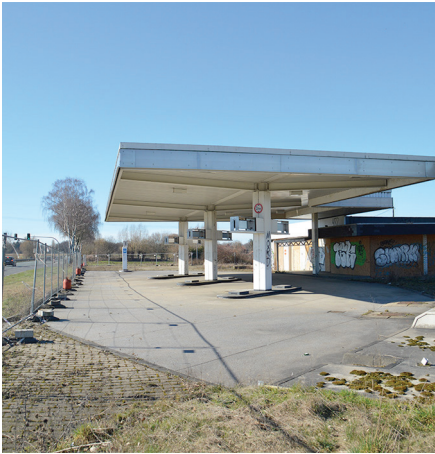
A 1.10 Beispiel einer modernen Ruine: seit Jahren leerstehende Tankstelle im Münsterland
