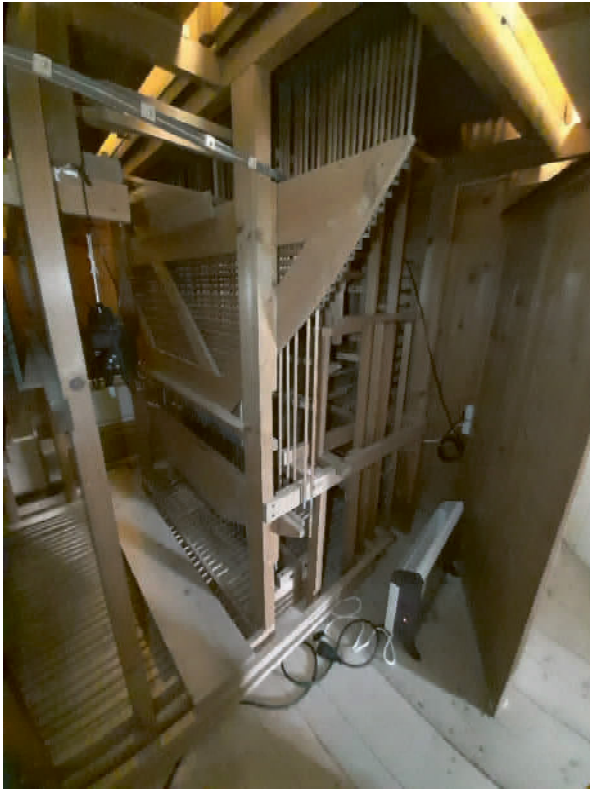
Abb. 3 oben Heizkörper im vorderen Bereich des Orgelgehäuses
