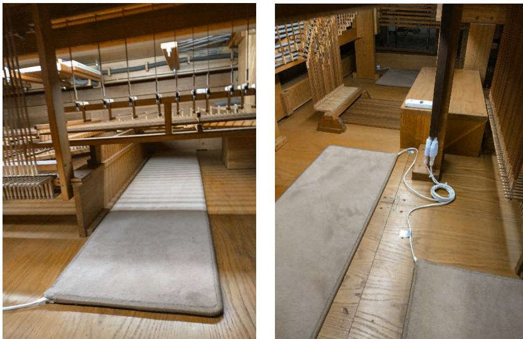
Abb. 53 Geseke: Heizteppiche in der Orgel. Im rechten Bild ist auf dem Kasten einer der fünf (weißen) Datenlogger zu sehen, die in der Orgel ausgelegt wurden.
