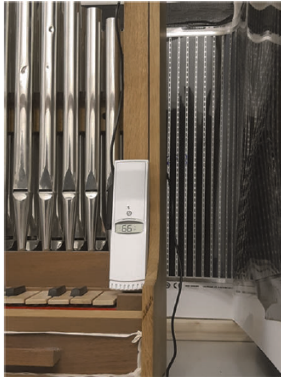
Abb. 47 Versuchsanordnung zur Wirkung einer IR-Heizbahn. Zu sehen ist links die Orgel, einer der Messfühler und die die hinter und neben der Orgel angebrachte Heizbahn.
