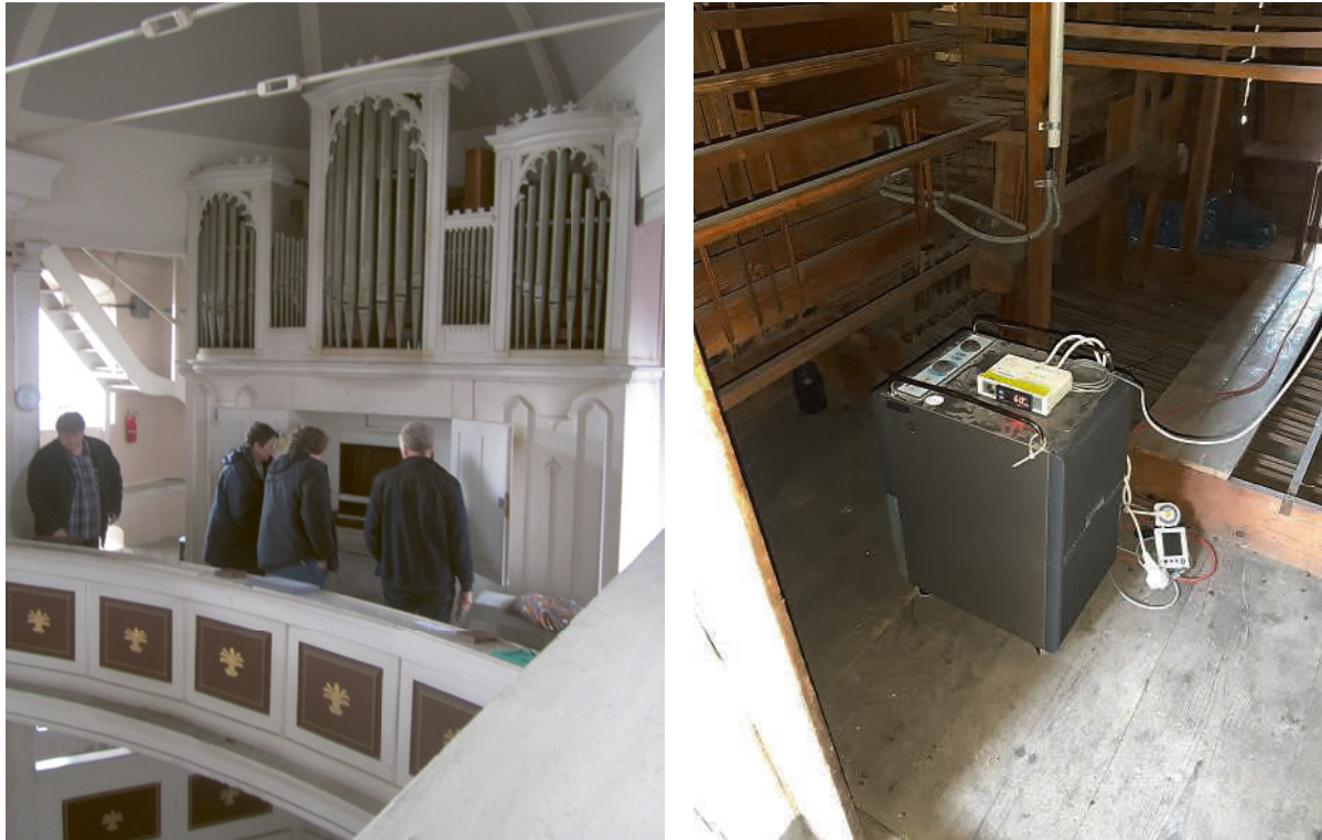
Abb. 61 Wöllnitz, links Ortstermin (2016), rechts der Raumlufentfeuchter mit dem Vorschaltgerät für die gezielte Zuschaltung des Entfeuchtungsprozesses in der Orgel (2020)
