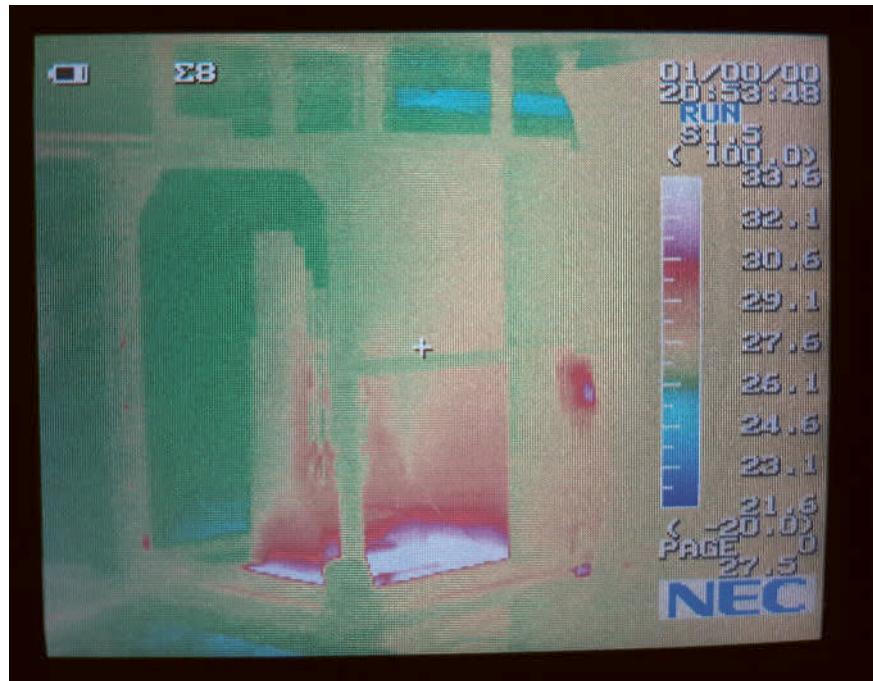
Abb. 15 während des Betriebs mit luftfeuchtegesteu- tem Heizteppich, 13.08.2020 15.00 Uhr bis 14.08.2020 08.30 Uhr Foto: 14.08.2020 08.30 Spreizung der Temperaturskala: 21,6 °C - 33,6 °C
