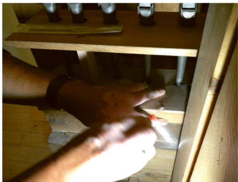
Abb. 13 Probestelle Messstelle 4, Oberseite Pfeifenstock über Windlade mit Metallpfeifen, 100cm über Fußboden, C- Seite
