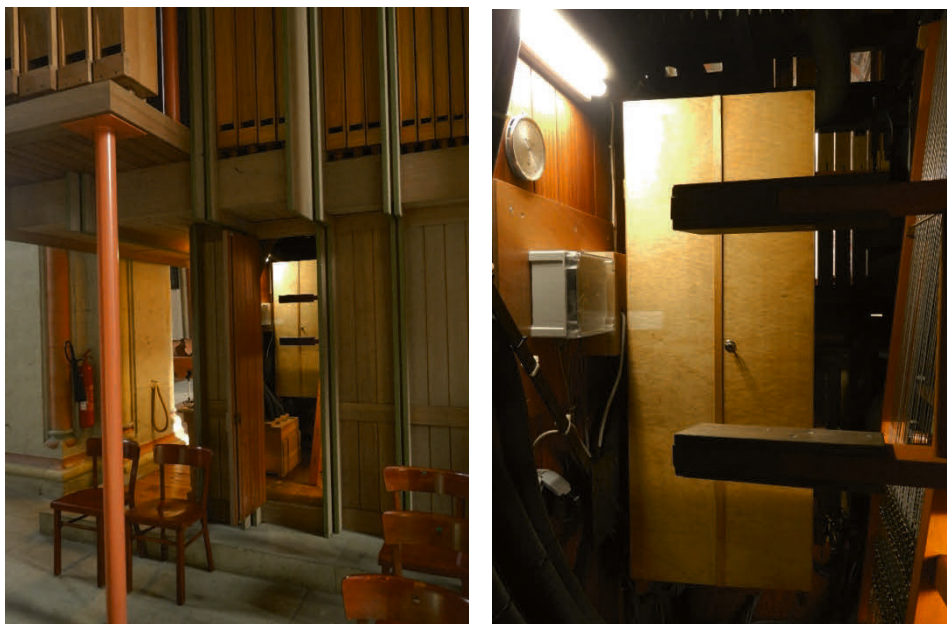
Abb. 75 (links) Rückseite des Orgelgehäuses von Westen aus betrachtet. Hinter der offenen Tür befindet sich der (rechts) Schaltschrank, dessen linke Tür als Probestelle für diesen Test verwendet wurde.
